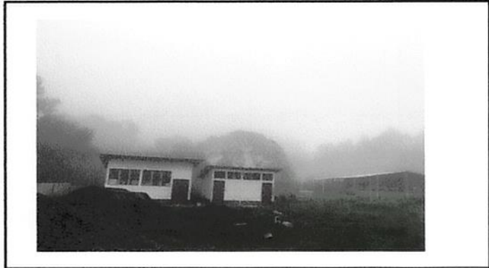
Foto 2: Mejoramiento de instalación de cocina y bodega.
